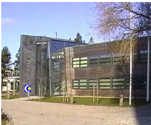
Geschäftsgebäude Metrologic in Horsholm
