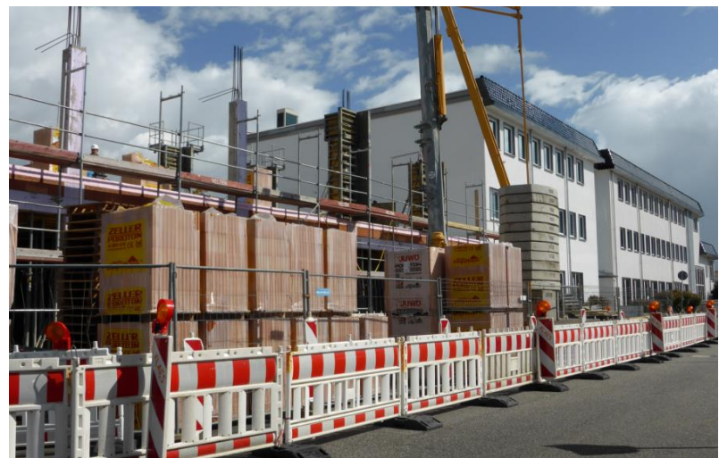
Baustelle am Standort Gießen
